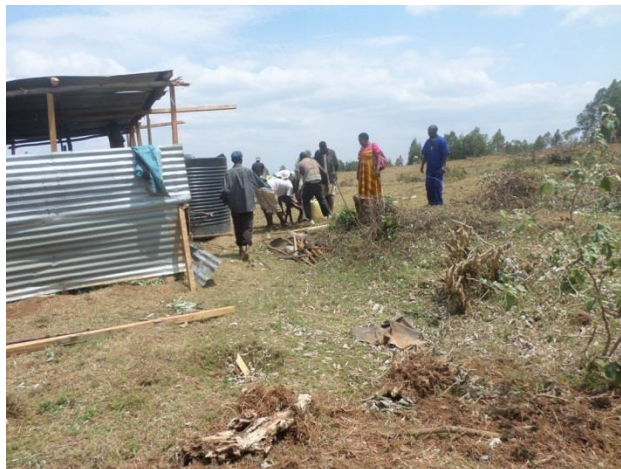
2. Opstellen van een werkkeet.
