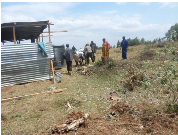
2. Installation d'une cabane de travail
